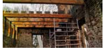
Die Restaurierung Sicherung und Erneuerung
